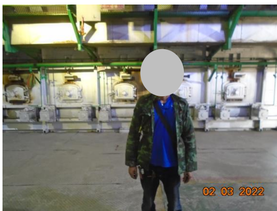
บริเวณที่มีระดับเสียงดังเกินกว่า 85 เดซิเบล (เอ) ของโรงไฟฟ้าในโรงงานน้ำตาล (บริเวณหม้อไอน้ำ)
